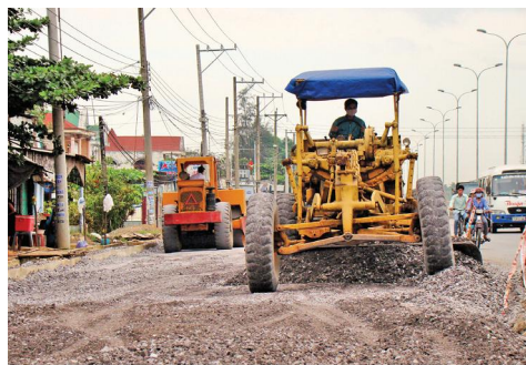
Thi công QL51.
